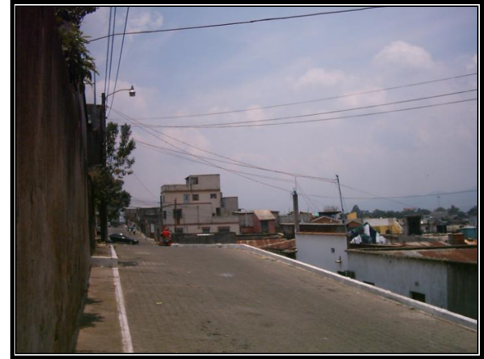
UBICACIÓN DE VIVIENDAS EN ZONAS DE ALTO RIESGO
