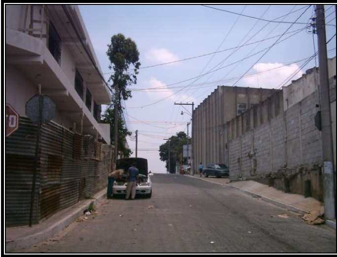
FALTA DE REGULACION DE LA DENSIDAD EN EL SECTOR
