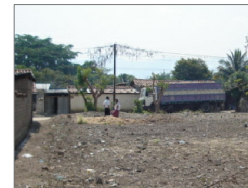
FOTOGRAFIA No x VISTA DE TENDIDO ELECTRICO
