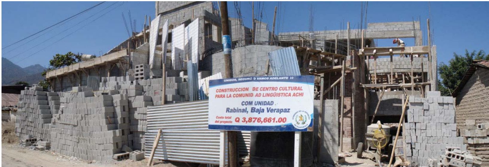
Img. 43: Fachada Este en Ejecución.
