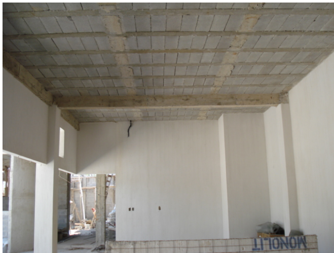
Img. 37: Salón de Usos Múltiples.
