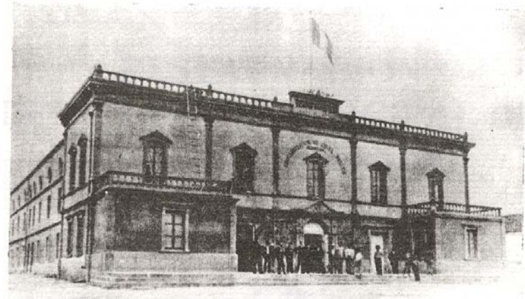
Imagen 15: Fachada Original de Teatro Municipal.
