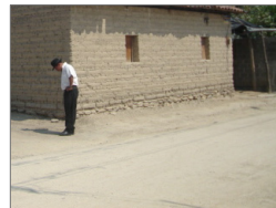
FOTOGRAFIA No x VISTA DE POZO DE VISITA DE RED DE DRENAJE MUNICIPAL
