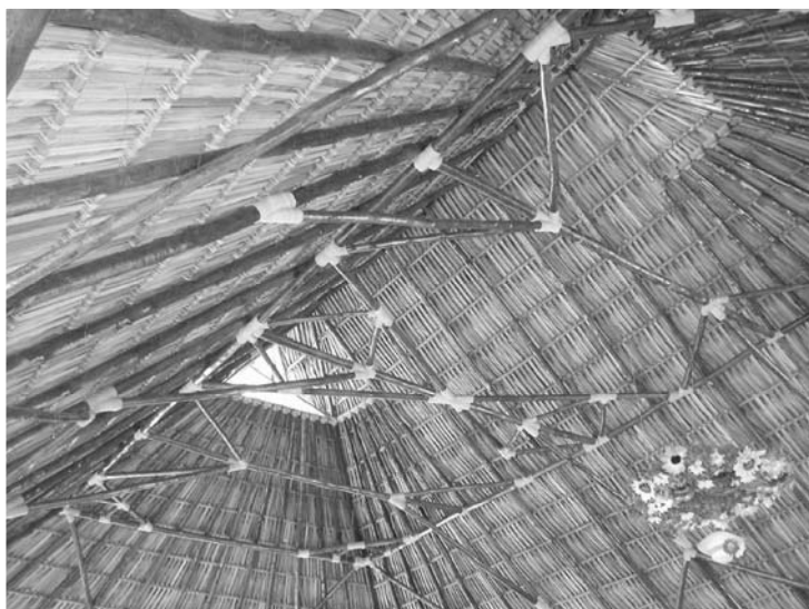
ARMADO DE ESTRUCTURA
