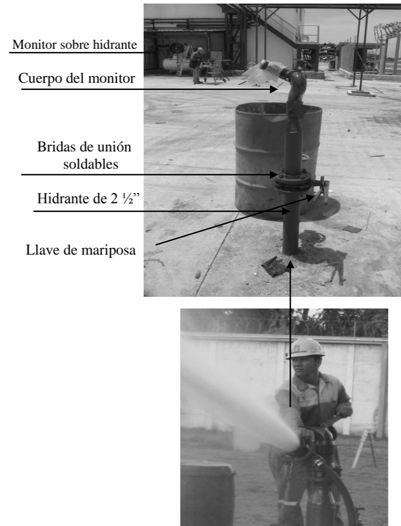
Figura No 54 Hidrante tipo Columna de 2 ½" y Monitor de 1 ½"
