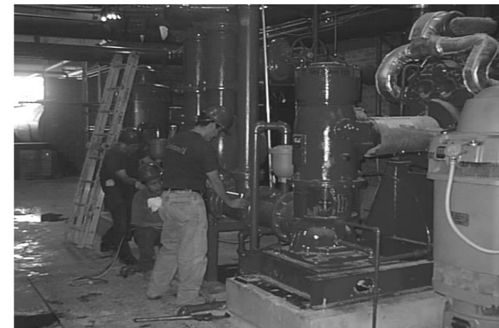
Ejemplo cuarto de bombas eléctricas
