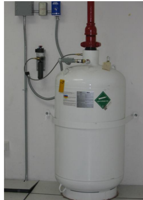
Figura No 39 Equipo principal en los cilindros de gas limpio
