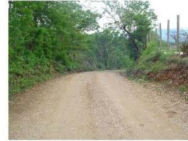
FOTO 28. Carretera que comunica a Chiquimula y San José La Arada.
