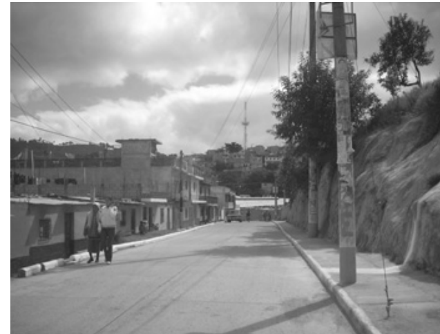
La mayor parte de edificaciones son de un nivel, de block y cubierta de lámina, aunque se observan algunas de dos o más niveles.
