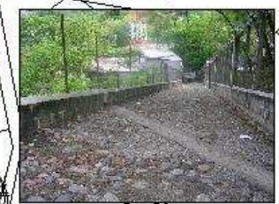
Fotografía No. 5: El terreno es de fácil acceso vehicular peatonal. Por esa vía circular vehículos livianos en doble vía.
