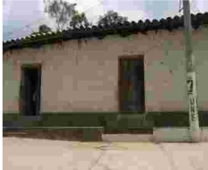
1- Deterioro Físicos, hongos debido a la humedad causados por las lluvias, además se observa contaminación visual por anuncios políticos. Alteración conceptual por la utilización de gradas de concreto en la entrada principal.
