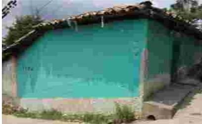
13- Deterioro Físico; Desprendimiento de acabados en los muros, manchas causadas por la humedad. Putrefacción de elementos de madera, aleros puertas y ventanas, grietas en los muros causados por sismos.
