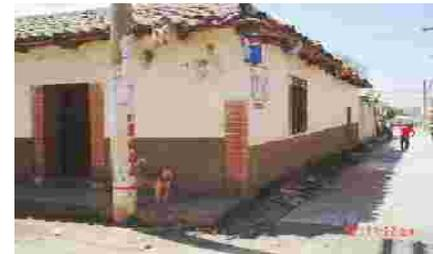
11- Consolidación del tejado, utilizando colores afines y pendientes. Integración del muro aplicando repello y colores similares a las demás fachadas
