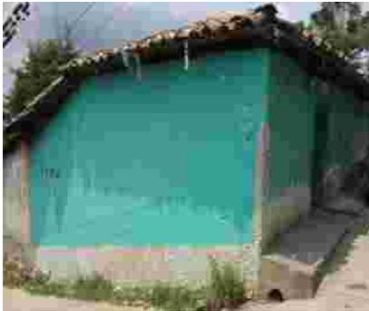
13- Consolidación de grietas y agujeros utilizando material similar, reintegración de piezas de madera en el alero, ocultar las tuberías de instalaciones eléctricas
