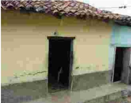
5- Consolidación de repello, restitución de pintura, consolidación del techo utilizando pendiente similar y teja de barro.
