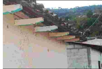
6- Se aprecia humedad en la pared causada por las lluvias de la región, además desprendimiento de piezas en el tejado.
