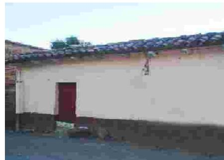
2- Liberación de humedad, eliminar granceado en base del muro e integrar acabado igual al de la parte superior, consolidación de repello restitución de pintura.
