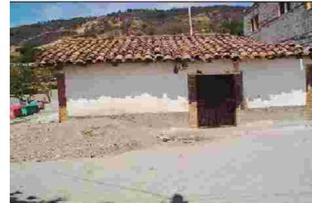
7- Cambios cromáticos en elementos de madera (aleros y puertas) manchas causadas por la humedad y cambios de textura con materiales y sistemas constructivos ajenos al lugar.
