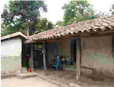
9- Deterioros Físicos, Desprendimiento de acabados en muros. Disgregación y grietas en el adobe, manchas causadas por la humedad. También se aprecian Alteraciones conceptuales. Cambios de pendientes en el tejado.
