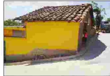
15- Alteración Espacial: Transformación tipológica de la arquitectura, utilización de losas planas que cambian la pendiente de la cubierta también se aprecia, desprendimiento de teja en el techo.
