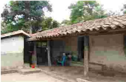
9-Integración de muros aplicando repello y pintura de colores similares a las demás fachadas, reintegración de piezas de madera en el alero.
