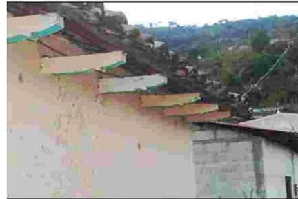
6- Liberación de la humedad, aplicación de repello y pintura en los muros. Integración de muro de cerramiento con materiales similares a las fachadas, consolidación, de piezas de madera en el alero.
