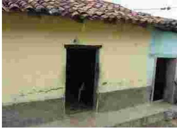
5- Deterioro físico: Se aprecia hongos en las paredes de fachada principal de la vivienda que producen decoloración en el zócalo.
