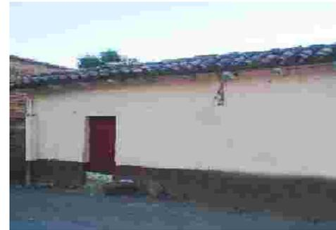
2- Deterioros Físicos. Humedad en los muros causados por lluvias y desprendimientos de los acabados, grietas en muros causados por sismos.
