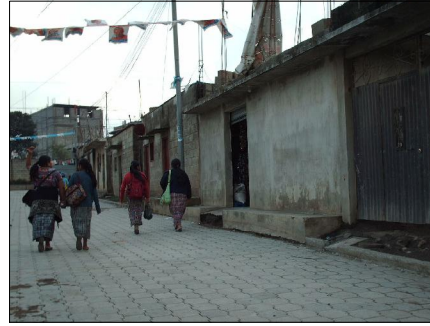
Tema 2.5.3 Algunas planificaciones urbanas se demuestran una zona de ciudad al caso áreas vehiculares y peatonales pero sin las normas constructivas se se cumple creando una inestabilidad constructiva
