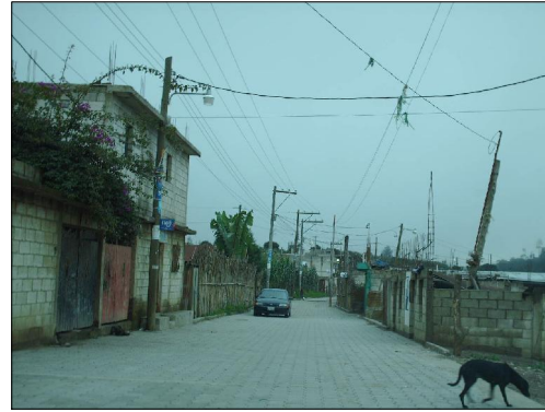
Foto 3.2.2 Baja Vulnerabilidad a los desastres gracias a la adecuación de calles y un control municipal en la adecuación de la infraestructura tanto sanitaria como telefónica
