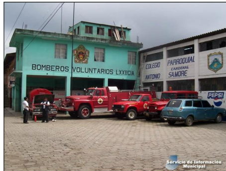
7002129 Estacion de Bomberos voluntarios
