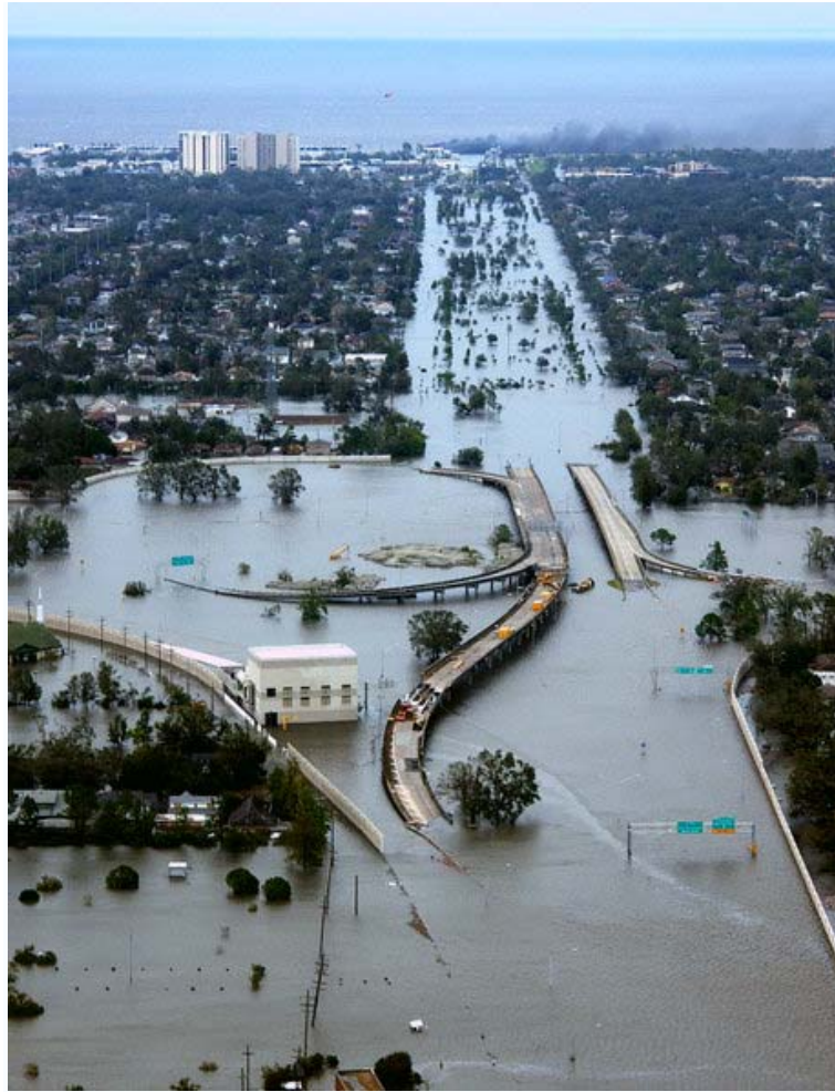
Inundación de I-10/I-610/ West End Blvd. Connector y áreas aledañas a New Orleans + Metairie, Louisiana. (1)
