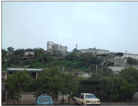
Foto 3.2.4 Alta vulnerabilidad a los desastres debido a la inadecuada construcción en áreas adecuadas y seguras siendo áreas con pendientes menores del 50° además de observarse una alta densidad poblacional.
