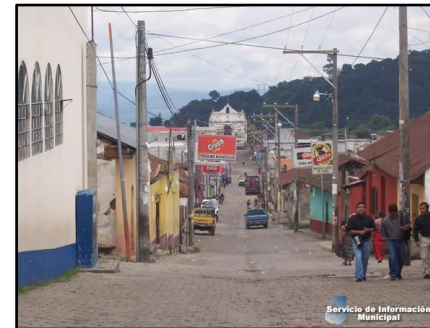
Foto 3.2.6 Mediana vulnerabilidad a los desastres debido a las pendientes y la infraestructura deficiente en drenajes de aguas pluviales y negras debido a la alta densidad del área
