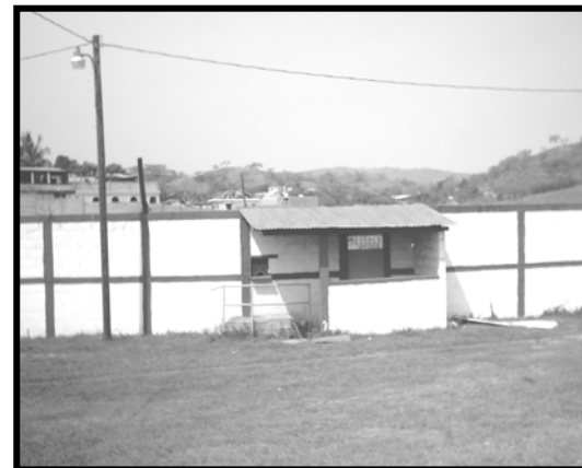
Fotografía 5: Taquilla actual. Los usuarios están a expensas del clima.
