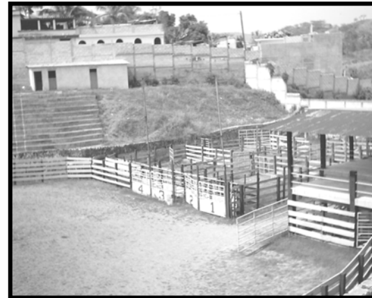
Fotografía 4: Área de montas y evacuación de toros del rodeo hecho de madera, la cual se encuentra un tanto deteriorada.
