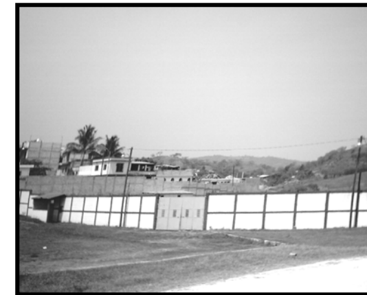
Fotografía 2: Ingreso al Coliseo sin caminamientos. Afectando la locomoción.
