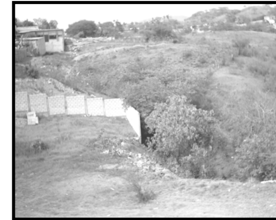
Fotografía 6: Limitante del terreno hacia colindancias en la parte posterior, una parte con muro y otra directamente hacia el barranco.
