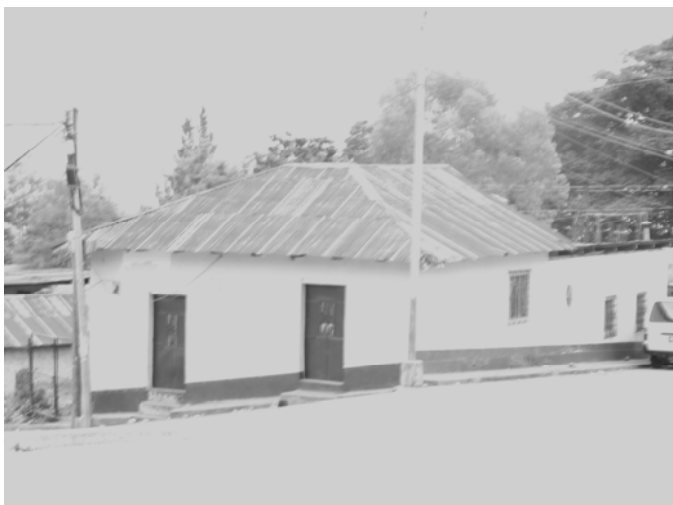
Foto No 2. Tipología Constructiva. Vivienda con paredes de block y techo a 4 aguas con lámina galvanizada con artesanado de metal. Fuente: Propia.
