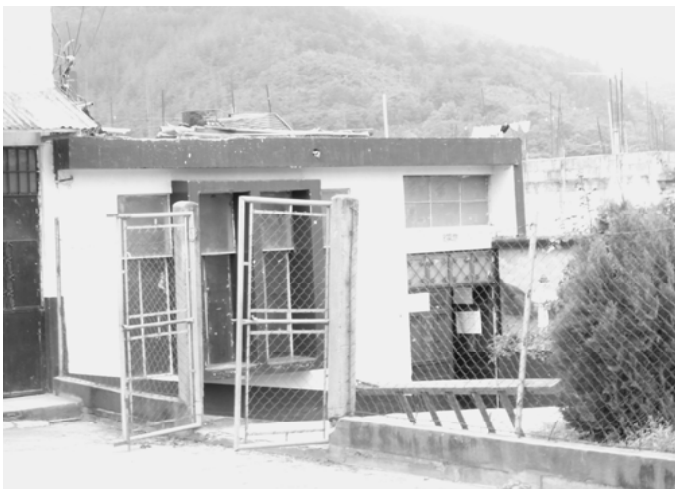
Foto No 6. Tipología Constructiva. Edificio de oficinas, paredes mixto-block, losa de concreto reforzado. Fuente: Propia.
