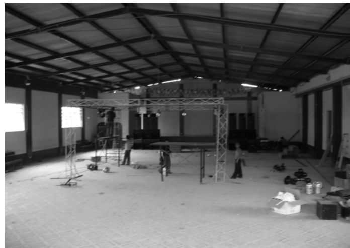
Foto No 7. Tipología Constructiva. Edificio de uso público, paredes de mixto-block, y techo de lámina troquelada, piso de granito. Fuente: Propia.
