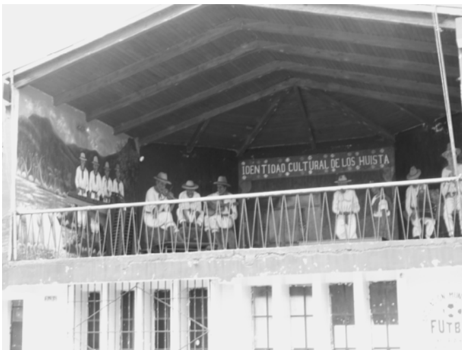
Foto No 5. Tipología Constructiva. Edificio de uso público, paredes mixto-block y techo con artesanado de madera y lámina galvanizada. Fuente: Propia.
