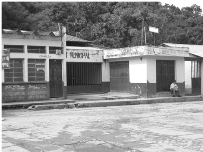
Foto No3. Instalaciones Culturales en la Región: Salón Municipal y Biblioteca de Santa Ana Huista. Fuente: Propia
