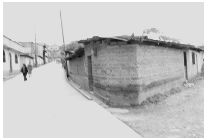
Foto No 8. Tipología Constructiva. El uso de adobe en la construcción de muros es menos frecuente, por la actividad sísmica y la falta de técnicas adecuadas. Fuente: Propia.
