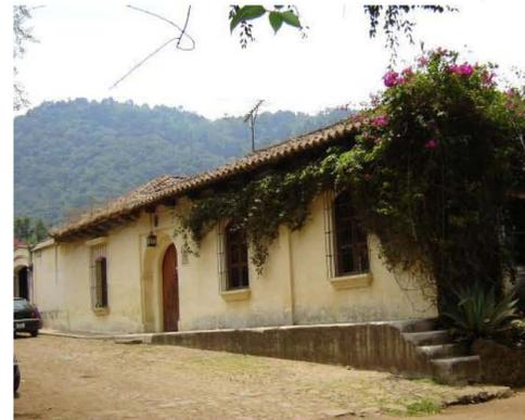
Foto de la fachada exterior principal de ingreso a la casa patronal en la cual se observa el uso de ventanas con repisas de piedra, cubiertas inclinadas con estructura de madera y teja de barro.
