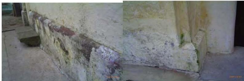
Presencia de manchas y humedad por causa de la lluvia a una altura aproximada de 40 centímetros a lo largo de toda la fachada Norte.
