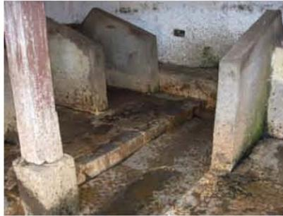
Se observa deterioro por causa de la humedad en el piso de piedra de la lechería.
