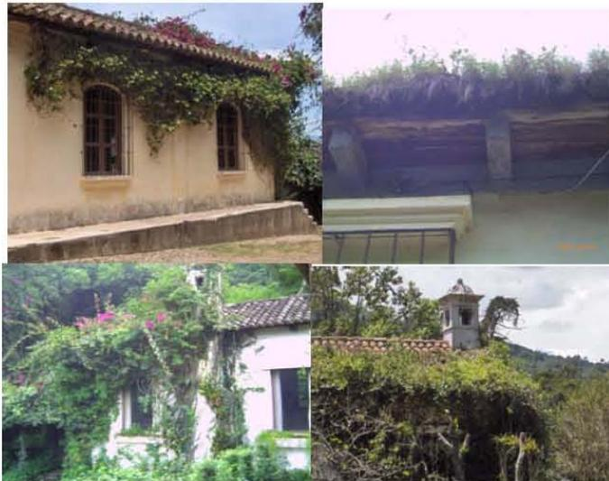
Presencia de plantas y microflora en las fachada Norte de la Casa Patronal y Lechería, por causas de la falta de mantenimiento y limpieza de los muros.
