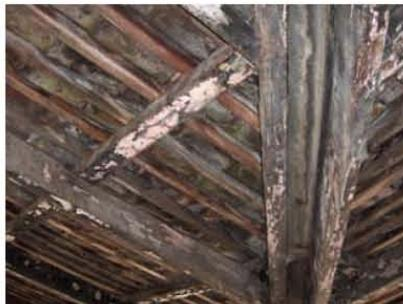
Presencia de sales a causa de la humedad y la falta de mantenimiento, en los elementos estructurales de la cubierta de la lechería.
