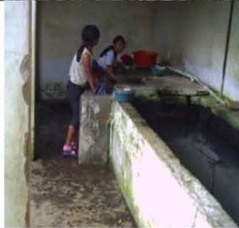
Presencia de eflorescencia en pisos de piedra y pilas causa de la humedad de las mismas.
