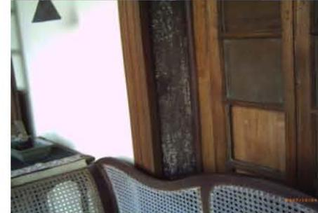
Daños en la madera de los marcos de las puertas por mal uso y por falta de mantenimiento.
