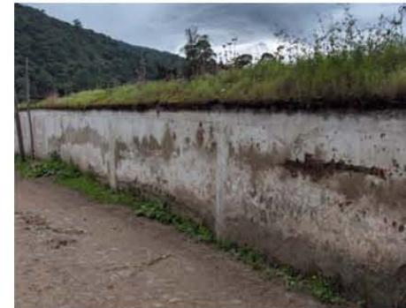
Daño en muros exteriores por desprendimiento del material que conforman los repellos de la fachada Este de la lechería.
