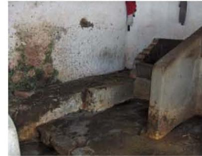
Desprendimiento del repello en muros y tabiques divisorios de los comederos de las vacas a causa de humedad y la falta de mantenimiento
