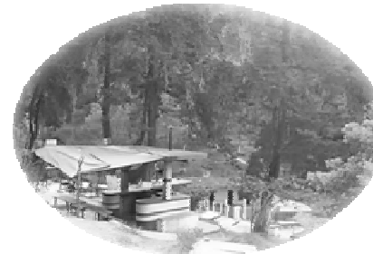
Fotografía 47. Situación Actual Balneario de Aguas Calientes.
