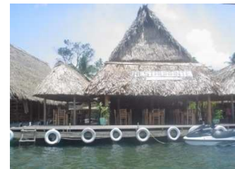
Fotografía 17. Restaurante a orillas del Lago de Izabal Guatemala.
