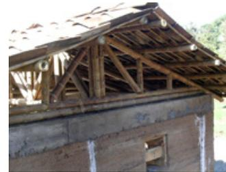
El empleo de ciertos bambúes se hace difícil por la combadura de las cañas, la prominencia de los nudos, la desigualdad de medidas y formas, y la proporción de variación longitudinal del ancho. La desigualdad y la conicidad, más marcas hacia el extremo superior de la caña, pueden hacer difícil obtener una construcción ajustada, a prueba de la intemperie y los insectos.
