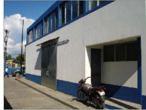
SE OBSERVA EL EMPLEO DE MATERIALES COMUNES, COMO LO SON VENTANALES DE VIDRIO, PAREDES DE BLOCK, ESTRUCTURA METÁLICA, PUERTAS DE VIDRIO, SISTEMA CONSTRUCTIVO TRADICIONAL.
