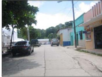
FOTOGRAFIA 85: Debido a la existencia de árboles (almendros) en la calle, las raíces han causado estragos en la misma ocasionando fisuras su superficie. Además contribuye a esto la falta de mantenimiento de la calle así como la trépidación de los vehículos que por allí transitan.
