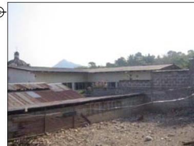
FOTOGRAFIA 48: Se observa el deterioro de la cubierta.
