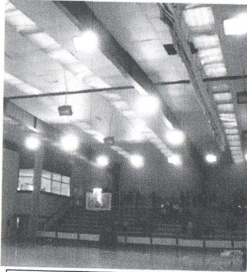
FOTO 3.9.3 F.58 Cancha techada de con la vista de la cabina de control.
