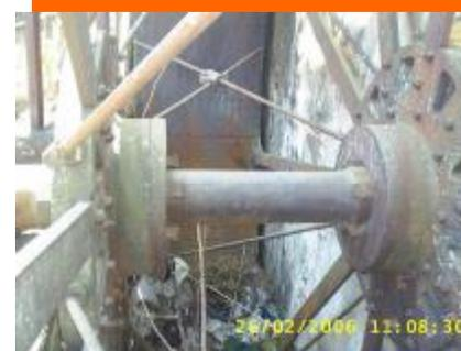
Puede observarse la corrosión de los tensores, Se ha convertido en basurero su interior, provocando un deterioro causado por humanos. año 2006. Foto propia
