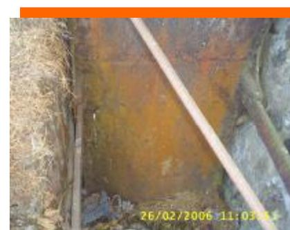
El fondo de la rueda Hidráulica o foso, se encuentra con alto grado de oxido y con basura en su interior, provocando un deterioro causado por humanos. año 2006. Foto propia
