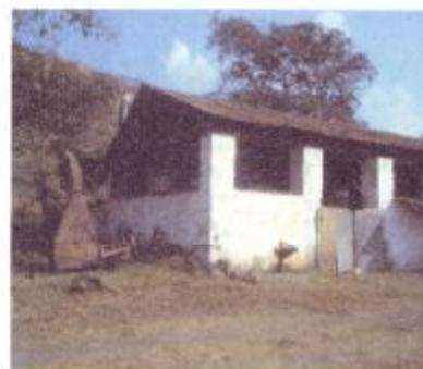
Estructuralmente tenía la característica de la forma constructiva del siglo XIX. Naves con techos a dos aguas, grandes aberturas para que saliera el calor ocasionado por el trabajo de producir panela.
