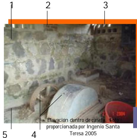
1. Muro de piedra fijadas con mortero de cal.
