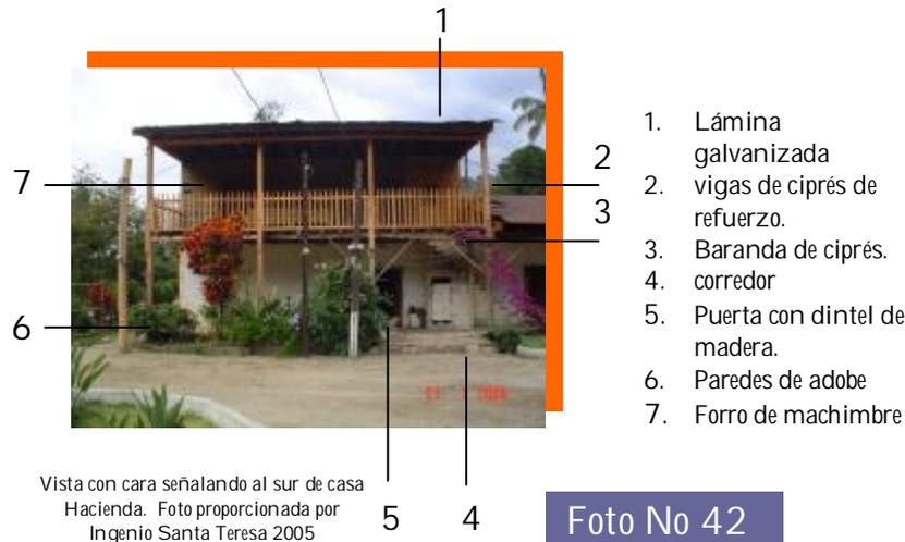
Artesonado para el techo de viga-parales de 3"x 3" y techumbre de lámina galvanizada que cubre ambientes de dormitorios y corredor.<sup>97</sup> Las vigas que soportan voladizos son de secciones 4" x 4".
