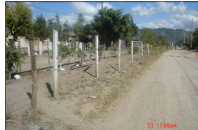
Imagen 2. TRAMO NO INVADIDO.
