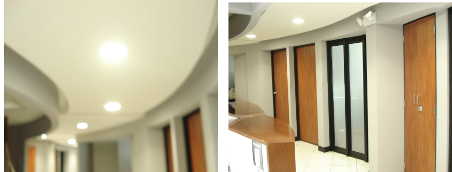
Imagen 6.9 Tabique y cielo falso con Tabla yeso. Fuente: Propia
