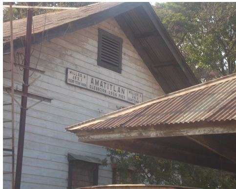
Imagen 4.1. Estación de Amatitlán-Palín. Fuente: Elaboración propia en visita de campo.
