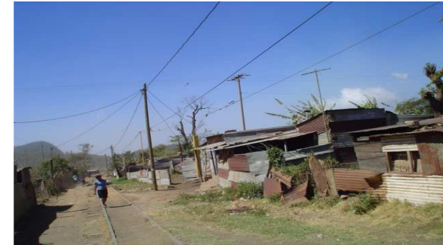
Imagen 1.1. Línea Férrea, Municipio de Amatitlán. Asentamiento: LA MARIPOSA. Fuente: Imagen propia captada en visita de campo.
