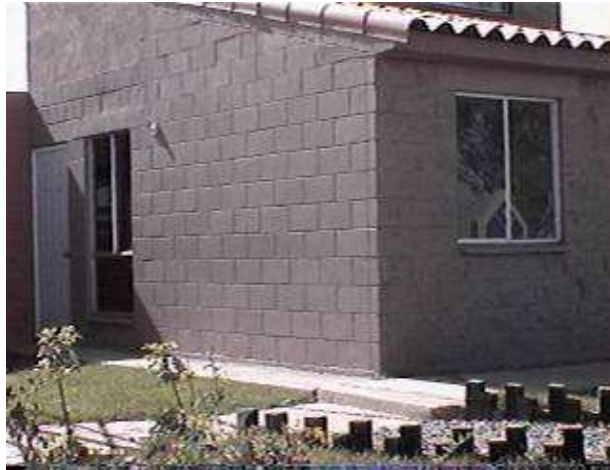
Imagen 6.1 Muro con block de cemento.
