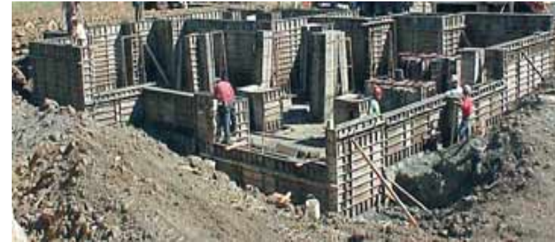
Imagen 6.2 Muros de concreto con formaleta.
