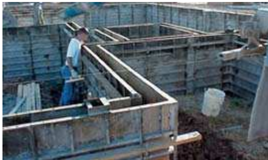
Imagen 6.4 Proceso de fundición. http://www.formaletas.com/Fundaciones.htm
