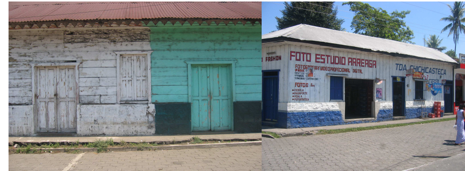
Imagen 6.12 Sistema Calicanto+madera machihembrada+lámina.
