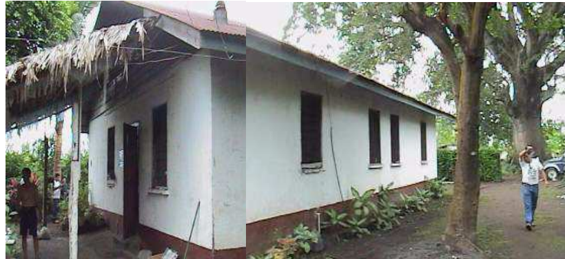
Imagen 6.13 Sistema de mampostería+lámina+madera.
