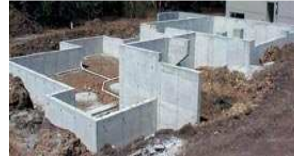
Imagen 6.5 Muro fundido y terminado http://www.formaletas.com/Fundaciones.htm
