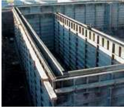
Imagen 6.3 Formaleta instalada y lista para fundición y ensambles. http://www.formaletas.com/Fundaciones.htm
