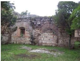
Vista muro oriente exterior capilla del Santo Cristo, es posible observar resanes modernos efectuados por el CNPAG.
