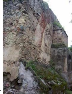
Muro exterior oriente de la Capilla Mayor, obsérvese la falta de acabados y el ataque de criptógamas.
