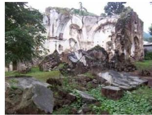
Vista del muro sur colapsado de la nave única, obsérvese la falta de arco toral en la capilla mayor.
