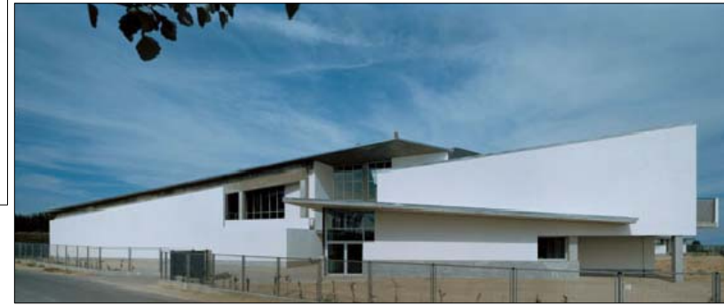
El juego de los volúmenes y cubiertas se conjugan para crear diversos matices a todo el edificio creando efectos de luz realmente acogedores
