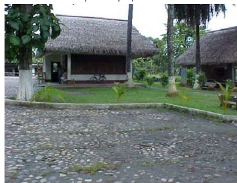
Fotografía 11. Área de parqueo
