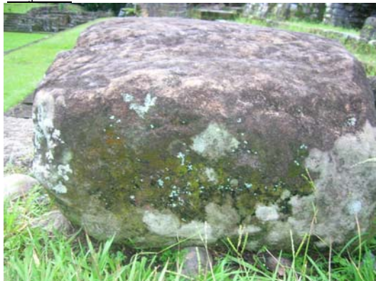
Se observan líquenes, musgos y decoloraciones.
