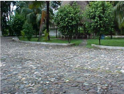
Fotografía 10. Área de parqueo.
