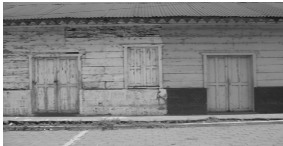
Ilustración 3.2 CASA COSTA SUR Fuente: Elaboración propia visita de campo
