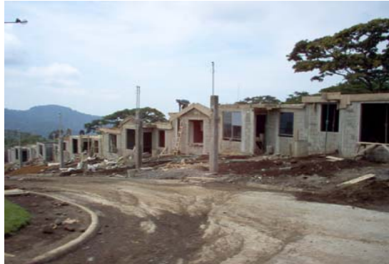
Levantado de block y cimientos corrido
