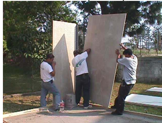
Montaje de paredes Sábado 26 (9:30 Hrs.)
