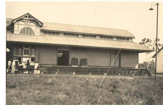
Ilustración 2.2 ESTACIÓN EN AYUTLA, CONSTRUIDA EN (1924) DESMANTELADA (1969)
