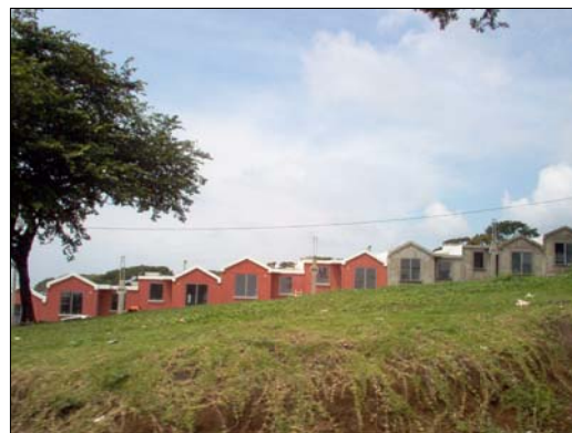
* EN LA SIGUIENTE FOTOGRAFIA SE MUESTRA LA LOTIFICACION TOTAL DE VALLE DE LAS FLORES OBSERVAMOS ALGUNAS NO HAN SIDO TERMINADAS, TODAS LLEVAN LOS MISMO MATERIALES CONSTRUCTIVOS Y ACABADOS
