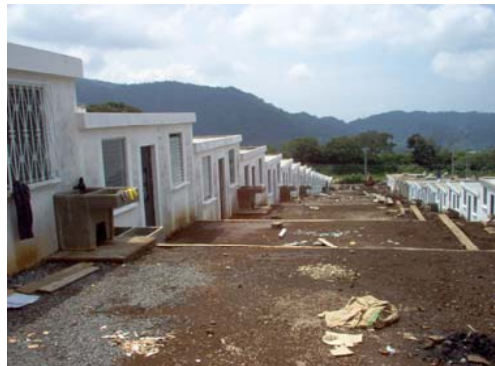
Levantado de block y cimientos corrido
