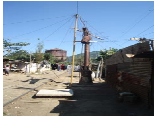
Ilustración 4.5. TRAMO FERROVIARIO AMATITLÁN-PALÍN ASENTAMIENTO EL SACRAMENTO Fuente: Fotografía propia tomada en visita de campo.
