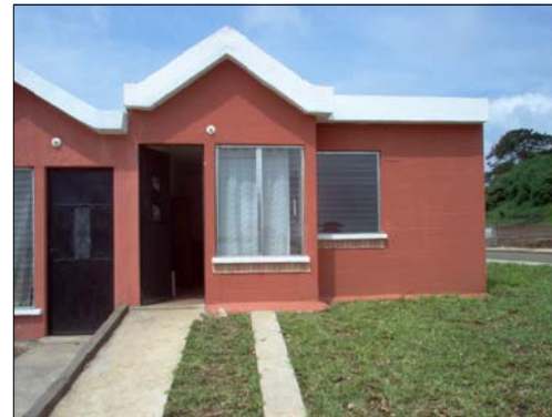
* FACHADA FRONTAL DE LA VIVIENDA, OBSERVAMOS QUE SON DE BLOCK, CON PUERTAS DE METAL, VENTANAS DE ALUMINIO GRIS, DE PALETAS, PISO DE CEMENTO LIQUIDO, Y LAS CASAS SON ENTREGADAS SIN BALCONES.
