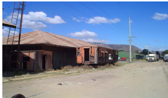
Ilustración 1.7. ESTACION DE AMATITLAN Fuente: Fotografía obtenida de documento digital de FEGUA.
