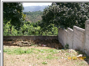
Foto No.3: La pendiente del terreno puede ayudar a evacuar el agua.
