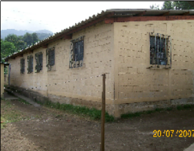
Foto No.1: Vista posterior del edificio 2, nótese en la cubierta que se insertaron láminas estales debido al deterioro de la lámina de fibrocemento.
