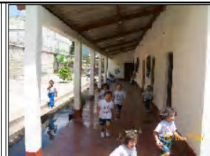
Foto No.4: El estado del piso es bueno, además la estructura y cubierta del techo no presentan daños.
