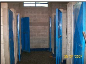
Foto No. 2: Vista interior de uno de los módulos de baños, éste cuenta con 6 inodoros y 3 lavamanos, todos en buen estado y funcionando.
