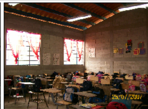
Foto No. 5: Vista interior de un aula, tiene ventilación cruzada, al piso es de torta de cemento.
