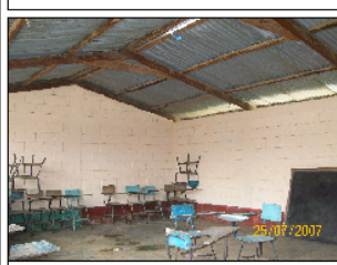
Foto No. 3: Vista de un aula en el módulo 6, la estructura de techo es de madera y la cubierta es de lámina metálica que está en regular estado, el piso es de tarja de concreto.
