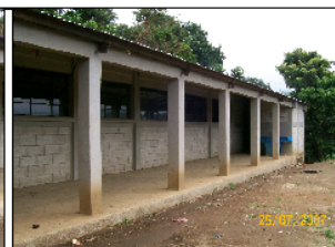
Foto No. 2: Vista del frente del edificio, el sistema constructivo es de mampostería de bloques reforzados, estructura de techo de metal y cubierta de lámina metálica.
