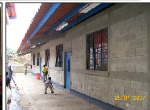
Foto No. 4: Uno de los módulos de aulas, el sistema constructivo es de mampostería de bloques reforzados y la estructura del techo es de metal, el material de cubierta es de fibrocemento.
