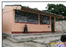
Descripción: El módulo 7 es un aula, no presenta mayor deterioro en su estructura.
