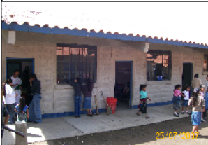
Foto No. 1: Vista del módulo administrativo, por falta de espacio algunos ambientes se utilizan como aulas, el deterioro es mínimo por su reciente construcción.
