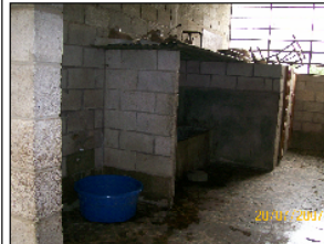
Foto No.4 Vista de una de las baterías de baño del módulo 4.
