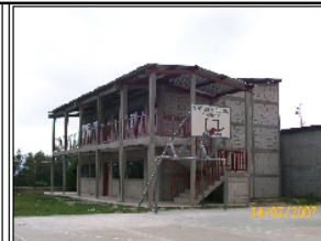
Foto No.4: El edificio 5, se construyó posteriormente, con características particulares como la medida de sus ambientes y su configuración (2 Niveles). Su estado está pendiente de terminar sus acabados finales.
