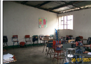
Foto No.1 Vista de una de las aulas del módulo 1, el piso es de torta de concreto y la cubierta de lámina metálica.
