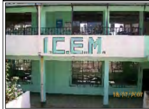
Foto No. 1: Debido a la pendiente del terreno, se observa el cambio de nivel dentro del pedio.
