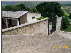
Foto No.1: Vista del ingreso al predio del edificio, note se la pendiente que puede generar caudal de aguas pluviales.
