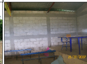
Foto No. 3: Vista interior parcial del salón comunal, se puede observar el área del escenario, en general el edificio está en buen estado y no presenta deterioro.
