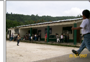
Foto No.1 Vista del módulo 1, el cual tiene dos aulas y una oficina, además se construyó un área anexa para la cocina, no presenta deterioro mayor en sus elementos aunque su construcción data de 1992.
