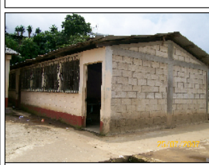
Foto No. 2: Vista del módulo de 2 aulas, que sirve de bodega para los materiales de construcción, no presenta deterioro.
