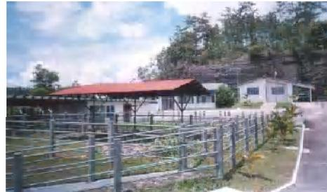
**Análisis:** El edificio de OIRSA cuenta con un módulo habitacional + laboratorios, está construido con columnas y cimientos de concreto + muros de block de 15\*20\*40 cms. y techo de lámina galvanizada. Existe un área para revisión de animales con corrales y área un observación. Para el área de observaciones e incineración los muros son de block y la cubierta es de lámina de asbesto cemento.
