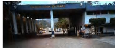
**Análisis:** El edificio actual está construido con block de 15\*15\*40 cms. y las columnas son de concreto reforzado, losa fundida, cuenta con cenefas que salen 1 mt. pintadas de color azul y los muros son de color gris, la ventanería es de hierro con vidrio claro las puertas son de lámina con hierro en color negro, la puerta principal es de vidrio claro con marcos de aluminio en el extremo norte hay un talud las banquetas son fundidas.
