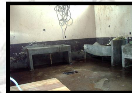
FOTOGRAFIA No 30 El establecimiento en general se encuentra en un deterioro al 100 % y actualmente no está prestando sus servicios, ya que en lo que respecta a su maquinaria no está en las óptimas condiciones de uso, sus paredes están destruidas, sus cerramientos verticales y horizontales no sirven, etc. Fuente: Rastro de Esquipulas/ Foto: Víctor Fuentes/ Mayo del 07
