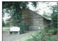
VISTA DE INVERNADERO
