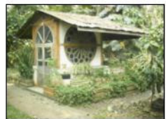
VISTA DE INVERNADERO
