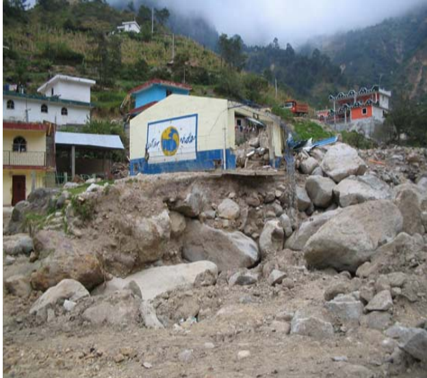
Desbordamiento río cabuz
