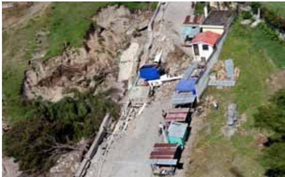
Fuente Derrumbe en Cupo
