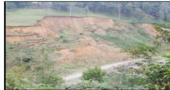
FOTO No. 8 EJEMPLO DE DERRUME EN CHUPOL
