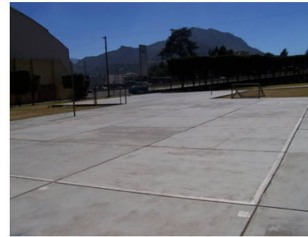
FOTOGRAFIA: cuatro canchas de voleibol, una de voleibol de playa y tres normales, cuenta con un área de 534 metros cuadrados.
