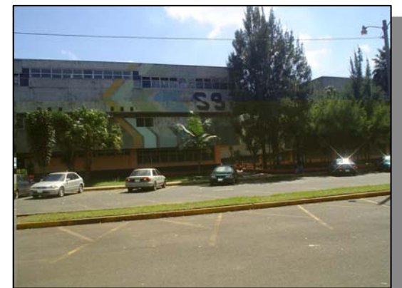
Foto No. 23 Análisis de Terreno: Entorno educativo Edificio S-9, (Fuente: Visita de Campo )
