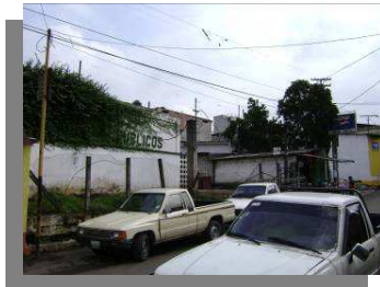
1. Servicios sanitarios convertidos en bodega y áreas en abandono.
