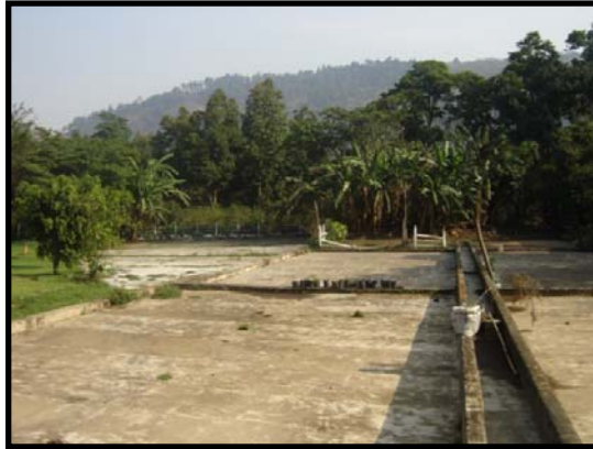
Fotografía 53. Vista de patios de secado. Espacio abierto.
