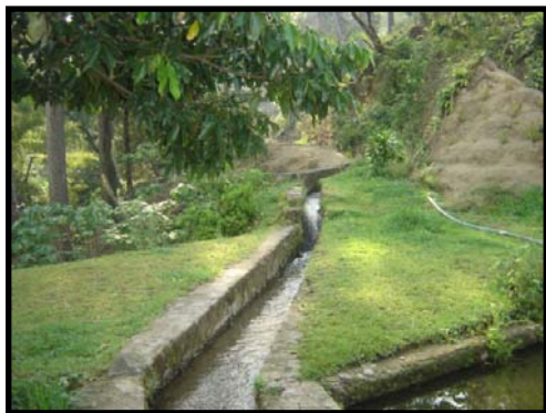
Fotografía 30. Canal de agua de toma, proviene de río (sin nombre).
