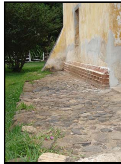
Fotografía 76. Reparaciones en acabados de muros.
