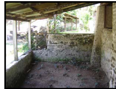
Fotografía 83. Corredor fachada Este.
