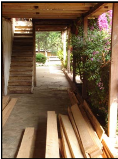
Fotografía 75. Reemplazo del material en columnas en corredores.
