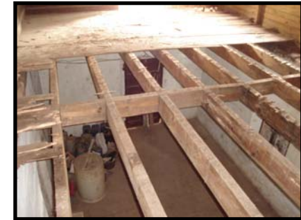
Fotografía 71 a 73. Reemplazo de material en cielo falso. Parales, tendales y duela.
