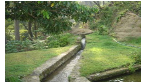
Fotografía 27. Canal de toma de agua, Finca El Rincón.
