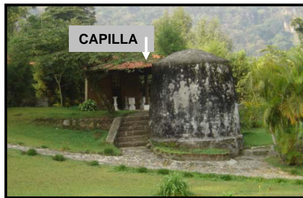
Fotografía 48. Silo de granos. Nodo, sitio de interés.
