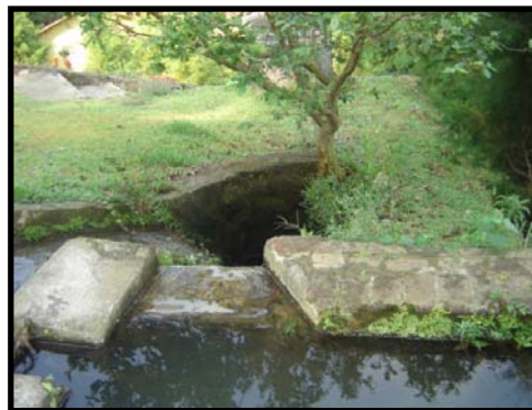
Fotografía 31. Estanque de captación de agua y su ingreso subterráneo.
