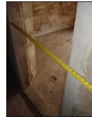
Fotografía 74. Reparaciones en acabados de muros
