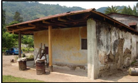
Fotografía 70. Reemplazo del material en columnas en corredores.
