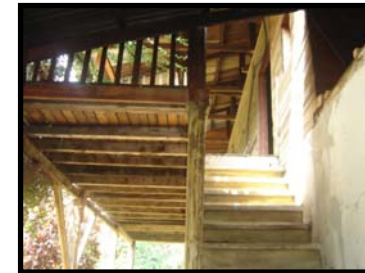
Fotografía 66 Gradas hacia segundo nivel.
