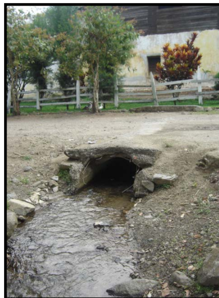
Fotografía 34. Agua de toma en zanja.
