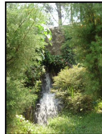
Fotografía 32. Paso de la toma para continuar su paso subterráneo dentro del Casco..
