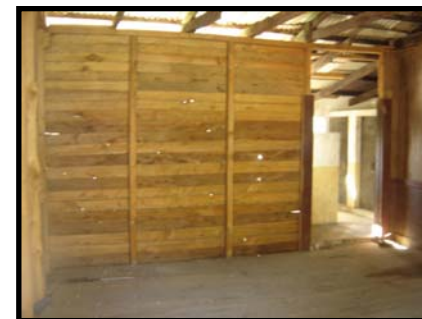
Fotografía 77. Reemplazo de madera en tabiques.
