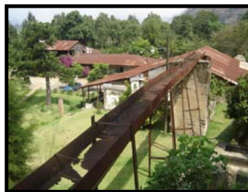
Fotografía 89. Fachada sur desde toma de agua.
