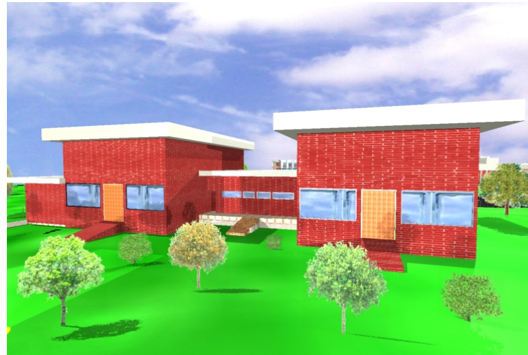
FOTO 55: VISTA POSTERIOR DEL ÁREA DE MANTENIMIENTO
