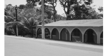
Vivienda popular conservando sus techos inclinados.
