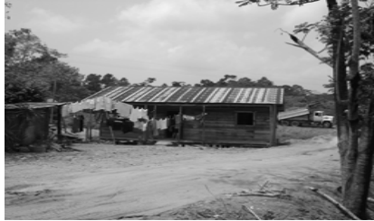
Vivienda en la salida de Entre Ríos ya demolida en el 2006.
