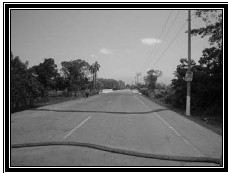
Se observa los postes de Luz Eléctrica
