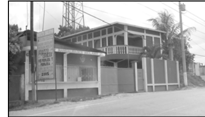
Vivienda popular con muros de block y losa fundida.
