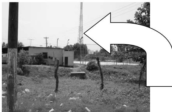
Una antena de telecomunicaciones
