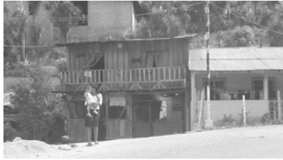
Casa de madera que no recibe ningún tipo mantenimiento.
