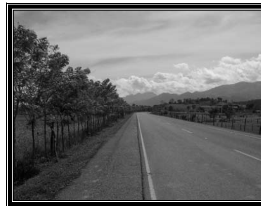
Carretera CA-13 en buen estado
