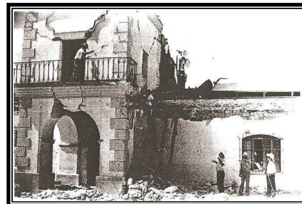
Año de 1976, debido al terremoto, el edificio sufre serios daños, por lo que las autoridades, deciden su demolición.
