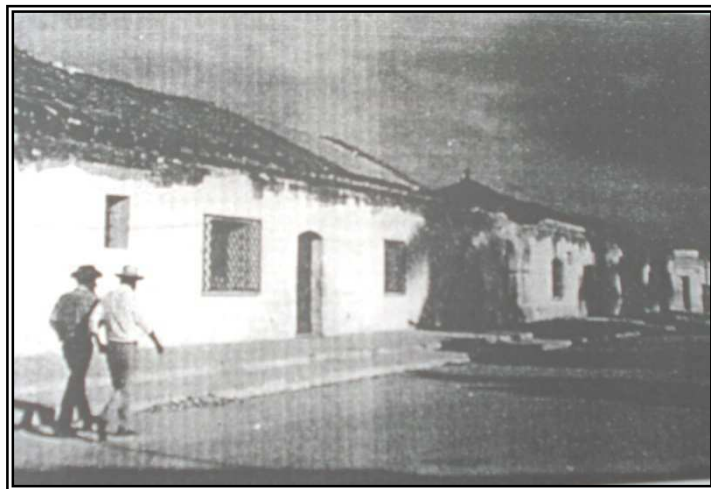
FOTOGRAFÍA DEL MONUMENTO DEMOLIDO AÑO 1976 DEL CUAL SÓLO QUEDARON LAS PAREDES DEL ACTUAL PRESIDIO DE HOMBRES, AQUÍ SE PUEDE OBSERVAR LA FORMA QUE TENÍA LO QUE HOY EN DÍA ES EL EDIFICIO DE GOBERNACIÓN.
