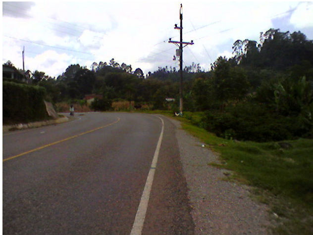
9. Se observa la instalación de Energía Eléctrica en el lado Este del terreno
