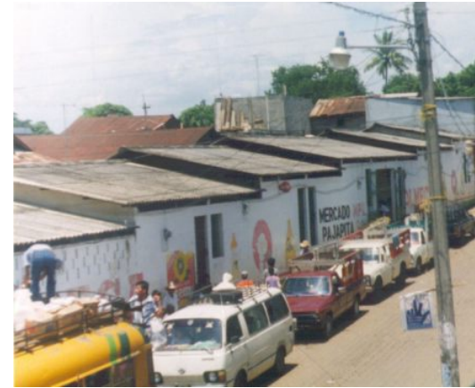
Área de carga y descarga del mercado (Foto 9) Calle Justo Rufino Barrios, Cantón Pueblo Nuevo (Diciembre 2007) Fuente propia.
