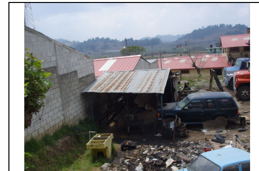
FOCO DE CONTAMINACION AMBIENTAL Y VISUAL TALLER MECANICO. FOTO No. 3
