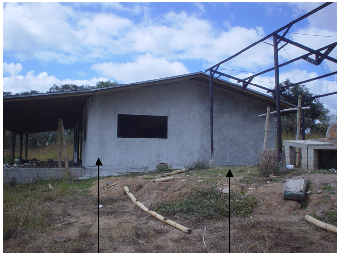
PARED EXTERIOR PARTE IZQUIERDA REPELLADA, PARTE DERECHA ENSABIETADA
