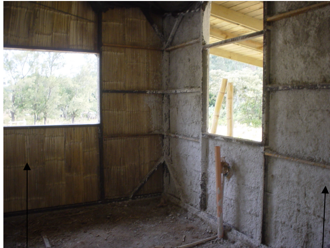
COLOCACION DE TODO EL BAMBU
