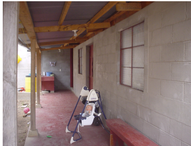
Vivienda ubicada en Mataquescuintla Jalapa
