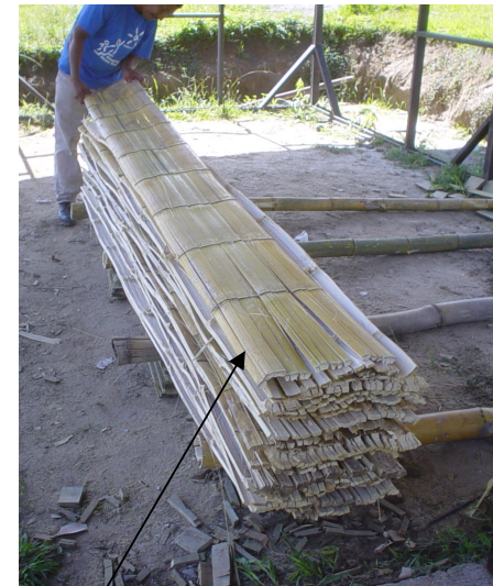
SE COLOCA EL PANEL YA CURADO FUERA DEL ALCANCE DEL SUELO Y SE APILA PARA EL SECADO DE 15 DIAS.
