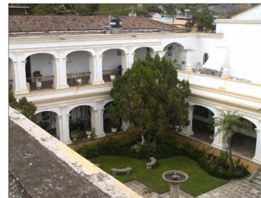
Fotografía No. 31 Vista 6 de la secuencia del interior del Palacio, ala sur y oeste del claustro mayor vista desde el techo del segundo nivel.
