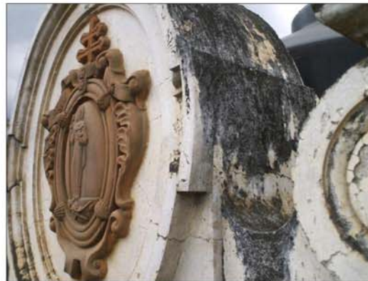
Fotografía No. 69 La espadaña de la fachada este presenta también manchas por humedad.
