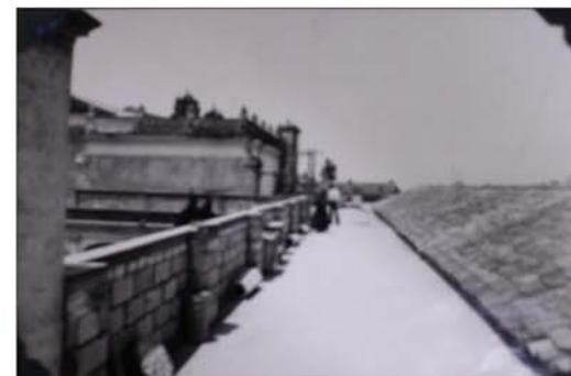
Fotografía No. 60 Interior del claustro mayor del convento. Falta completar arcada poniente y arcada sur del segundo nivel del claustro.
