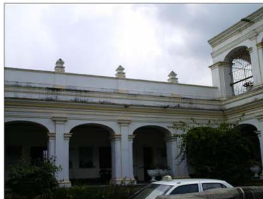
Fotografía No. 27 Vista 2 de la secuencia del interior del Palacio, ala norte y este del claustro mayor .
