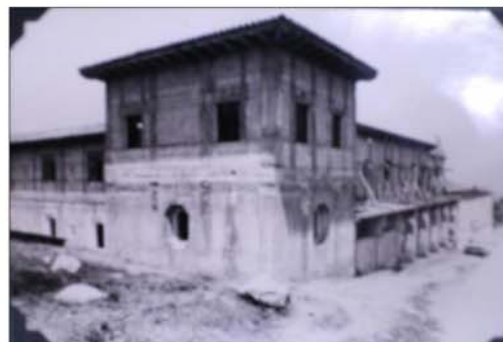
Fotografía No. 59 Fachada sur del Palacio. Falta completar repello del segundo nivel así como los trabajos exteriores aledaños.
