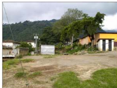
SERVICIOS SANITARIOS PÚBLICOS
