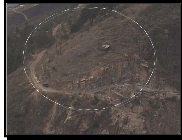
FOTOGRAFÍA No.58 VISTA PANORÁMICA DEL TERRENO MIRADOR TZANIMUL I
