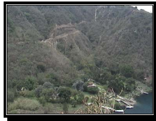
FOTOGRAFÍA No.44 VISTA DEL TRAMO CARRETERO TZANIMUL
