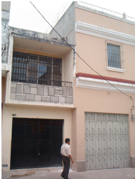
F. Entorno inmediato Sur, de Oeste a Este, sobre la 15 calle "A", donde se observa la diferencia en tipo de estilos.
