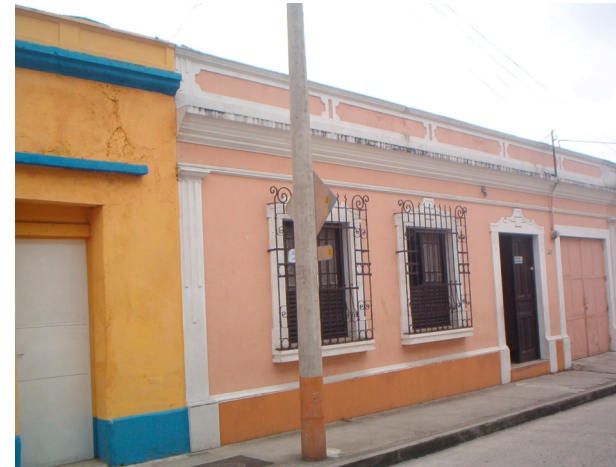
L. Inseto Objeto de estudio, Estado actual en la fachada Sur de Este a Oeste.
