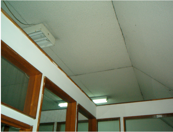
Se observa las fracturas en las uniones del cielo suspendido, instalaciones eléctricas y cables que están expuestas. Se observa la tipología de las divisiones o alteraciones de los espacios originales.
