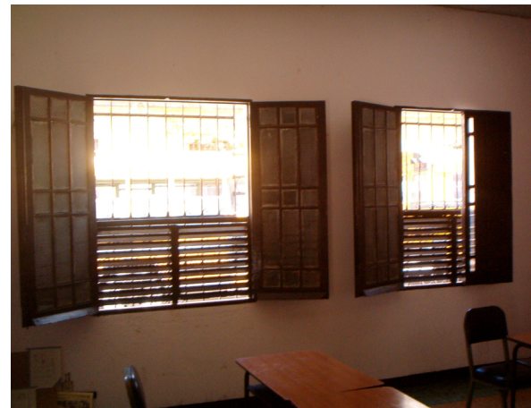
Las puertas y ventanas, que tienen contacto con el exterior muestran un avanzado grado de deterioro ocasionado por la prolongada exposición al sol, además el material con el cual fueron elaboradas están al límite de su vida útil.
