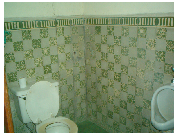
Los servicios sanitarios existentes son insuficientes y están en mal estado de conservación lo cual crea un mal aspecto, el piso de cemento tipo mosaico colocado en las paredes está manchado o desteñido, además cuenta con humedades y filtraciones.
