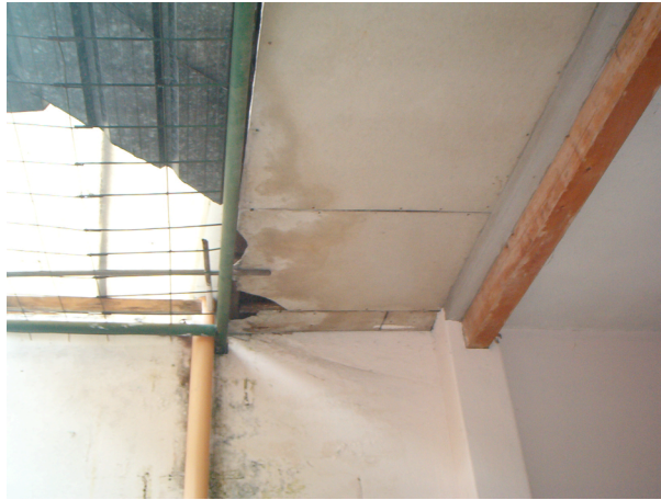
Debido al mal funcionamiento de las instalaciones de desalojo de agua pluvial, la filtración de agua de lluvia ha dañado la estructura del edificio.
