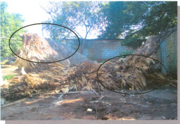
**Imagen 10** Colapso de Cubierta.
