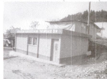
VISTA DE LA AUXILIATURA, LA CUAL PRESENTA UN TALUD JUNTO LA ESTRUCTURA LA CUAL PRODUCE HUMEDAD
