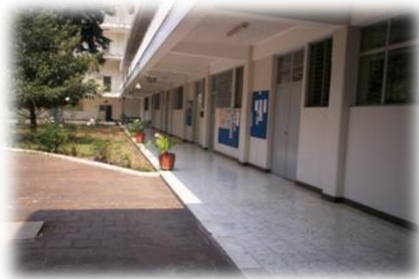
Foto 2 Pasillo exterior área aulas
