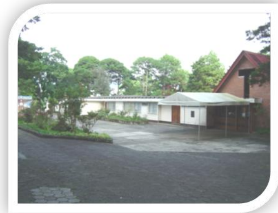
Foto 5 Fachada Principal Capilla
