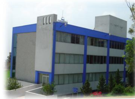
Foto 1. Vista del edificio Principal, Oficinas, Aula Magna, Salas de estar Filosofía y Teología
