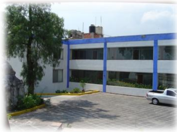
Foto 3 Fachada frontal (área de dormitorios)
