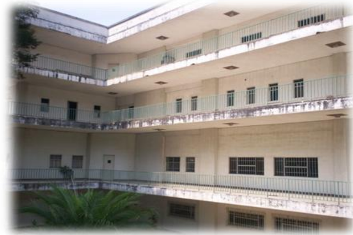
Foto 6 (vista corredor exterior edificio 1)
