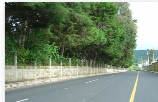
Foto Carretera A Aldea Piedra Parada
