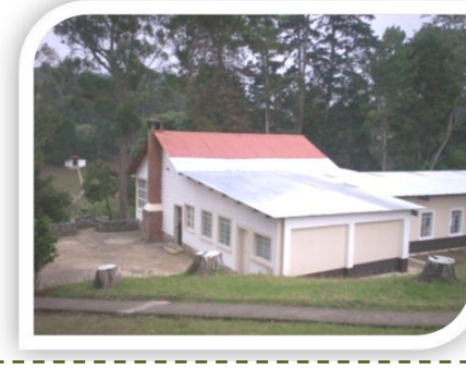
FOTO 14 VISTA EXTERIOR CASA DE RETIROS ?
