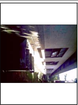
Foto No.7: La estructura del techo es de tendales y tieta de madera, con cubierta de lamina metálica y sus instalaciones electricas son expuestas.
