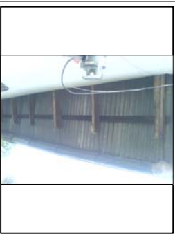
Foto No. 7: Cuenta con un sistema de captación de agua ya que en la aldea se escasea en ciertas épocas, el sistema capta el agua pluvial por medio de un canal y lo dirige a un depósito.
