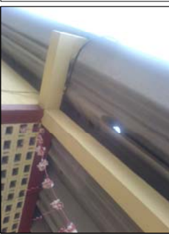
Foto No.5 y 6: Fese a que los módulos son construidos en diferentes ediciones, ambos contienen el mismo sistema de cubierta, fibrocemento y asbesto cemento, con instalación expuesta.
