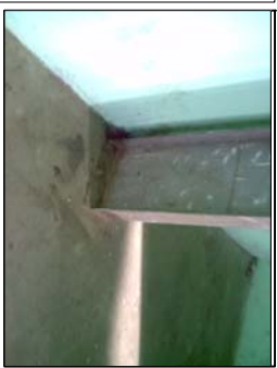
Foto No. 7: Las columnas son de metal y utilizan un sistema de anclaje tanto en el piso como en los tendales.
