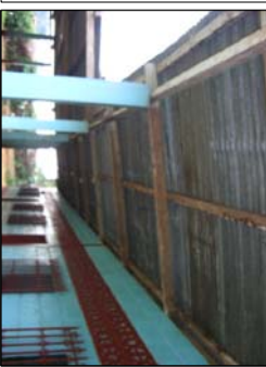
Foto No. 5 y 6: Los módulos cuentan con un sistema estructural de columnas de concreto y vigas y tendales de madera cubiertos de lamina metálica se encuentra en buen estado.
