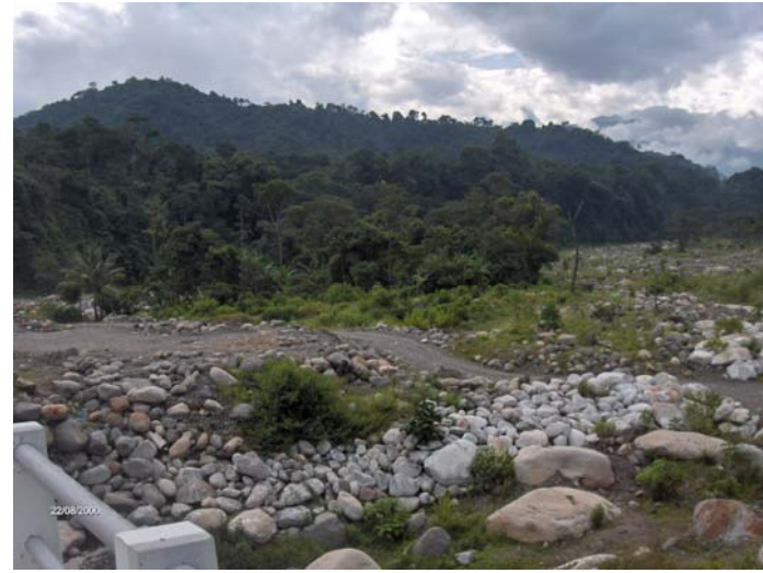
(Foto. No. 18 el río se salió de su cauce destruyendo todo lo que se interponía a su paso, incluyendo el puente el cual colapso ya que el río llegó al nivel del mismo).
