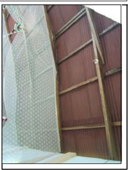
Foto No. 7: La cubierta del predio es de Lamina Metalica la cual se encuentra en buen estado, al igual que las vigas de madera de la estructura.
