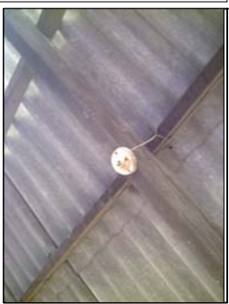
Foto No.7: La estructura del techo es de tendales y tieta de madera, con cubierta de lamina metálica y sus instalaciones electricas son expuestas.
