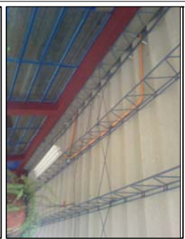
Foto No.5 y 6: Fese a que los módulos son construidos en diferentes ediciones, ambos contienen el mismo sistema de cubierta, fibrocemento y asbesto cemento, con instalación expuesta.
