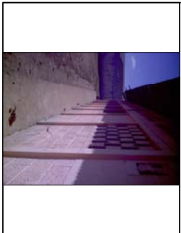
Foto No. 7: La estructura del techo continua como botadizo sobre la banqueta, su cerramiento es de block visto mas pintura.
