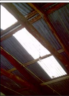
Foto No. 5 y 6: La estructura del techo usa un sistema de vigas de madera con cubierta de lamina metálica en buen estado, las instalaciones electricas son expuestas y si funcionan.
