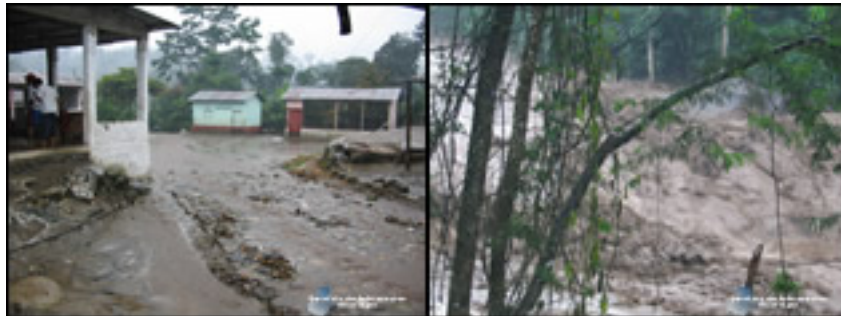
(Foto. No. 1 y 2 Tormenta STAN en octubre del 2005)
