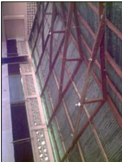
El botadizo vértica con un tipo de estructura de tija y ventales de madera, posee una cubierta de lamina metálica, esta se apoya en la solera de corona del edificio, la instalacion eléctrica es aparente.
