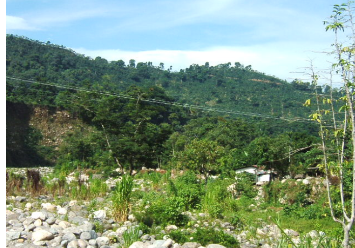
(Foto. No. 19 Se puede observar viviendas sobrevivientes a la tormenta ubicadas a orillas del cauce del río).
