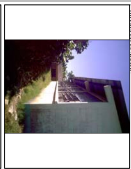
Foto No. 5 y 6: Este tipo de estructura no cuenta con su cubierta con un área para la captación de aguas pluviales, esto repercute en la cimentación ya que el agua cae al suelo y lo deteriora, debido a los excesos de humedad.
