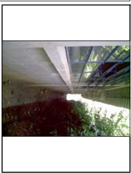
Foto No. 7: Las Ventanas son de marco de metal y hoja de vidrio y se encuentran en muy buen estado con su abatimiento hacia afuera.
