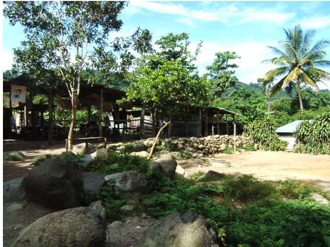
(Foto. No.24 Escuela ubicada dentro del sector 5 del municipio de San Pablo, San marcos. La cual se encuentra en mal estado Y vulnerable a distintas amenazas).
