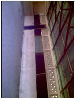
El botadizo vértica con un tipo de estructura de tija y ventales de madera, posee una cubierta de lamina metálica, esta se apoya en la solera de corona del edificio, la instalacion eléctrica es aparente.
