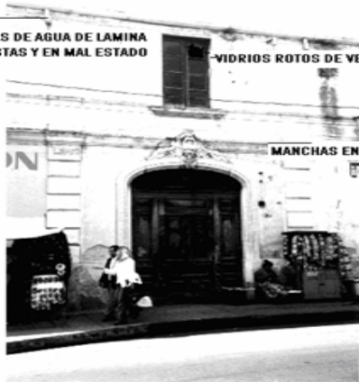
FOTOGRAFIA 50 PORTON Y VENTANA
