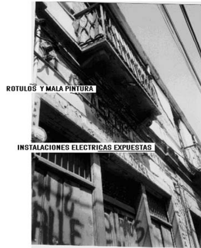
FOTO 52 DETALLE DE BALCON
