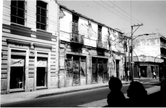
Foto 28 Cornisa sobre 9 a . Av.
