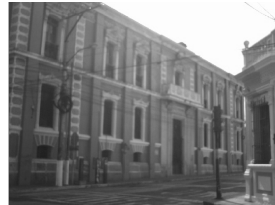
FOTO 84 ANTIGUO EDIFICIO DEL REGISTRO DE LA PROPIEDAD DE INMUEBLE ARQUITECTURA NEO CLÁSICA AFRANCESADA
