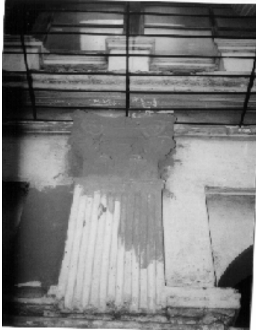
Foto 24 columna en patio
