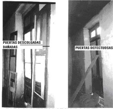
FOTO 68 PUERTAS SEGUNDO NIVEL
