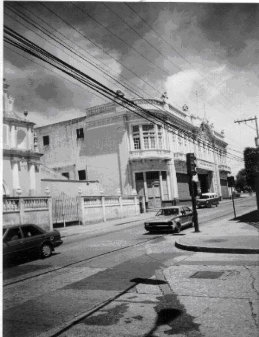
FOTO No 5 Edificio público REGISTRO DE LA PROPIEDAD INMUEBLE 9ª. AVENIDA SUR Y 13 CALLE
