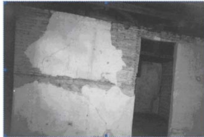
FOTO 26 MURO DE BAJAREQUE
