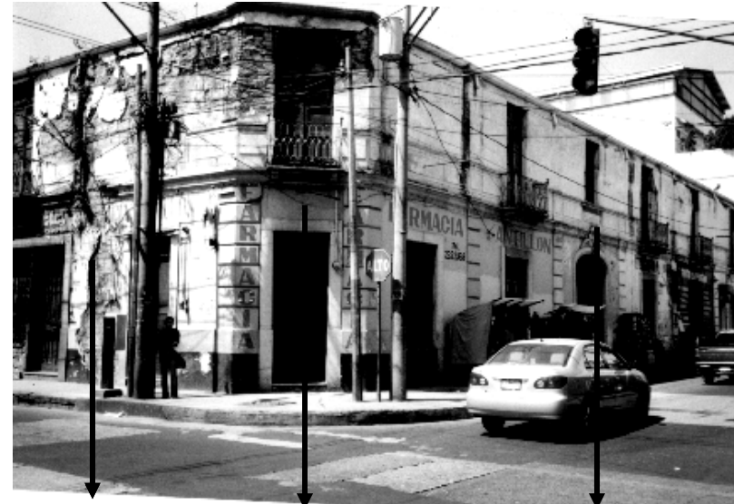
9ª. AVENIDA SUR FACHADA FRONTAL 12 CALLE
