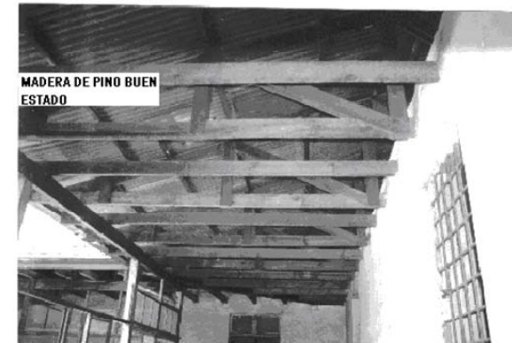
FOTO 75 TIJERAS ESTRUCTURA DE TECHO
