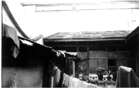
Foto 32 cubierta del techo
