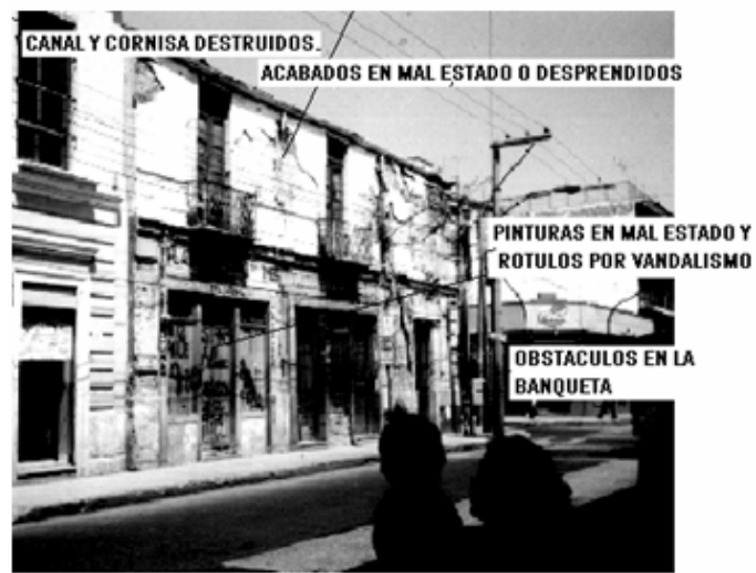
FOTO 45 FACHADA SOBRE LA 9a AVENIDA ZONA 1
