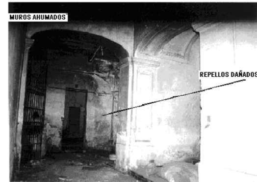
FOTO 67 INGRESO A GRADAS
