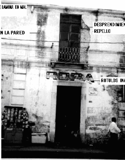
FOTO No 48 DETALLE BALCON Y PUERTA
