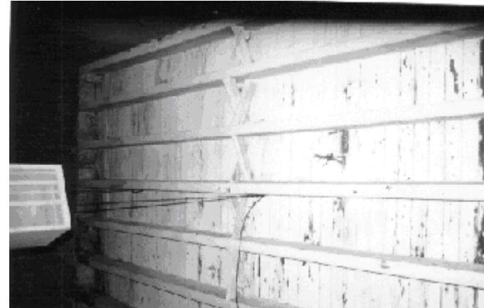
Foto 30 estructura de entrepiso
