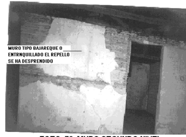
FOTO 73 MURO SEGUNDO NIVEL
