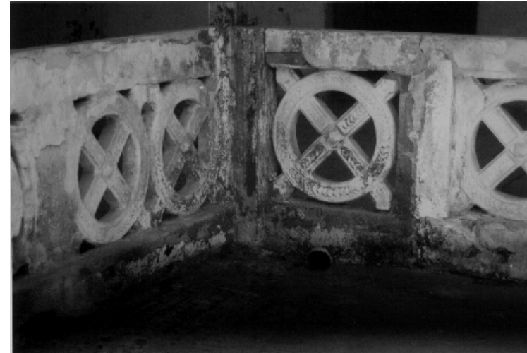
Foto41-A- Detalle de pasamanos en planta alta
