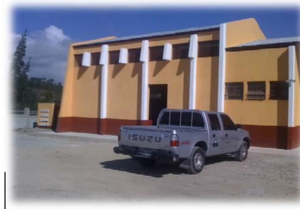
Fotografía b.1. Elevación Frontal Rastro Municipal de Jalapa. (Fotografía Cecilia Villanueva Feb. de 2008)
