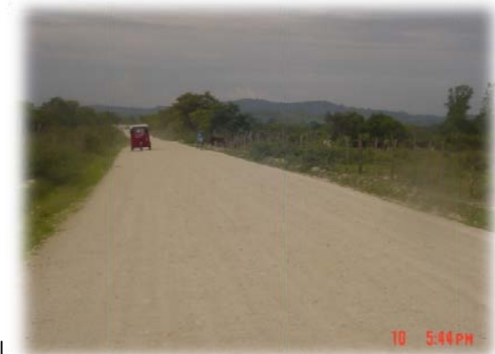
Fotografía 2.12.1.d. Carretera que Conduce hacia la CA1 (Fotografía Cecilia Villanueva Febrero de 2008)
