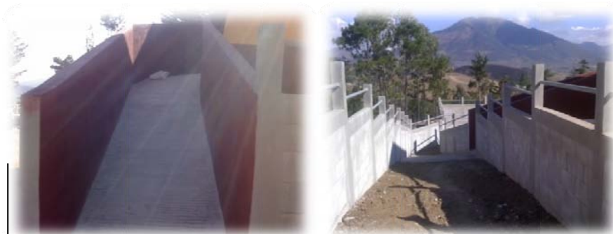
Fotografía b. 2 Área de Ingreso de Ganado Mayor y Menor del Rastro Municipal de Jalapa.
