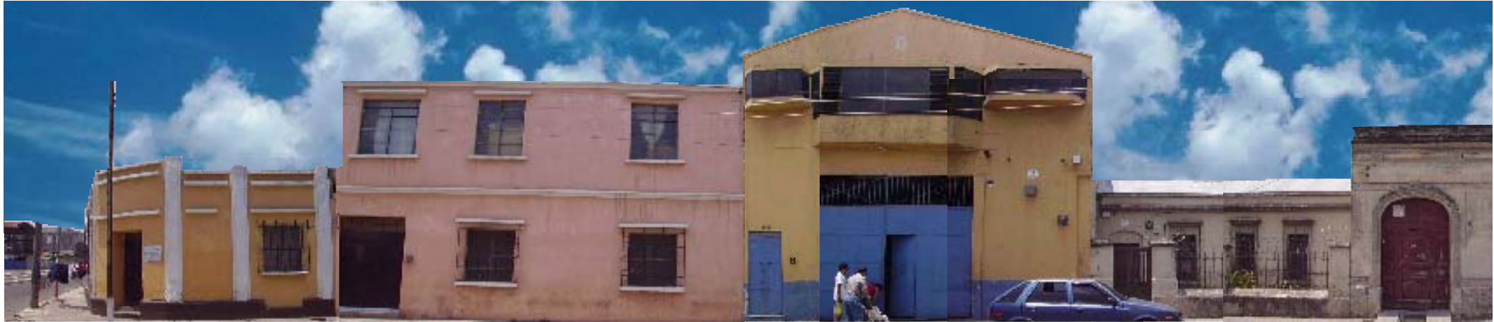
12 Calle Sur entre 14 Avenida y 13 Avenida Larguillo No. 3-A
