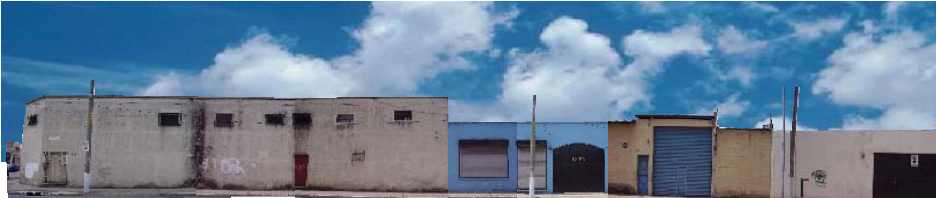
12 Calle Sur entre 13 Avenida y 12 avenida Larguillo No. 4-A
