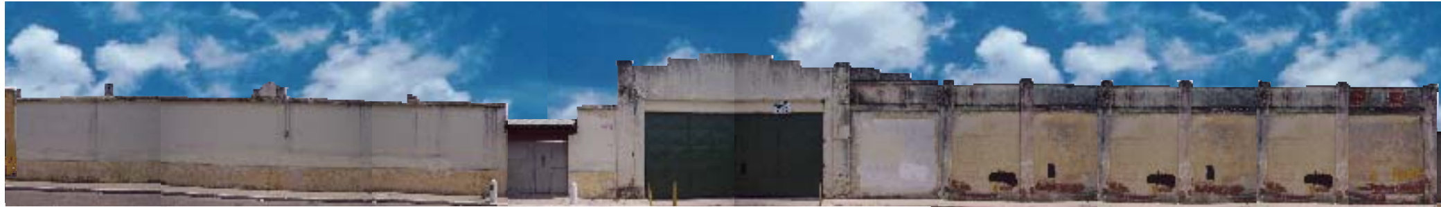
12 Calle Norte entre 13 Avenida y 14 Avenida Larguillo No. 2-B
