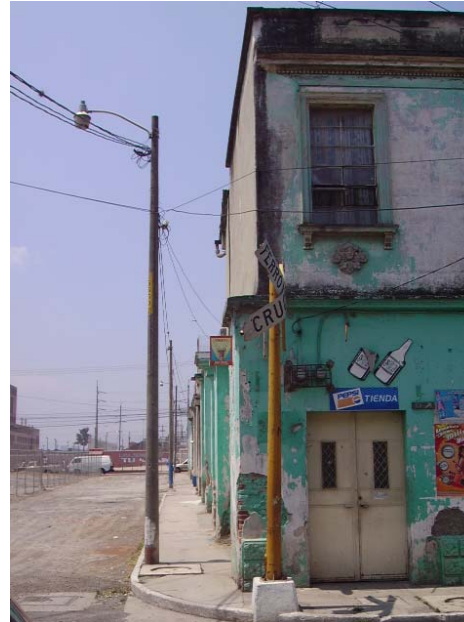
Fotografía 16. Poste de concreto con luminaria. Ubicación 12 calle esquina 14 avenida, zona 1, Barrio Gerona, ciudad de Guatemala.
