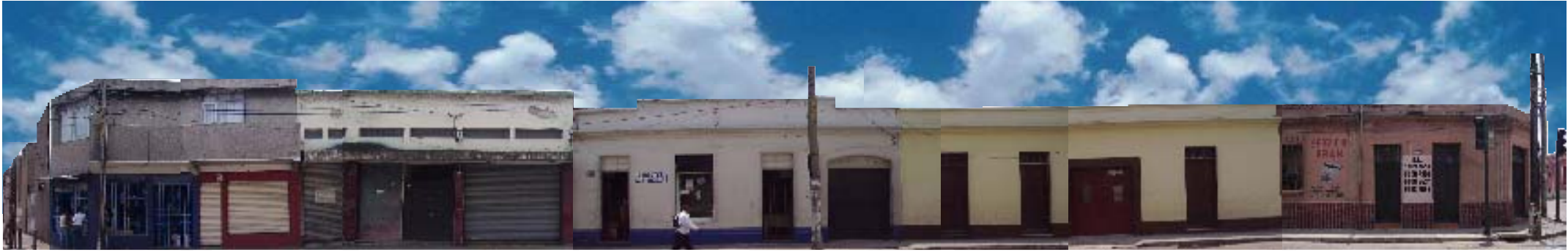
12 Avenida Este entre 12 Calle y 12 Calle "A" Larguillo No. 11- C
