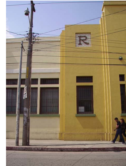
Fotografía 21. Poste de telefonía metálico. Ubicación 10ma. Calle entre 13 avenida y 14 avenida, zona 1, Barrio Gerona, ciudad de Guatemala.
