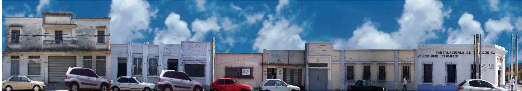
13 Calle Norte entre 12 Avenida y 13 Avenida Larguillo No. 9-B
