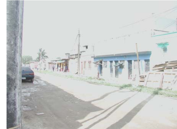
Fotografía 5. Desnivel existente del terreno. Ubicado en la 10ma. Calle y 14 avenida, zona 1, Barrio Gerona, Ciudad de Guatemala.
