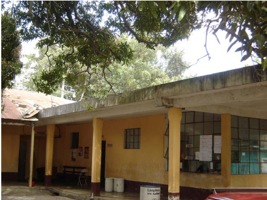
Vista de la junta que existe actualmente con el nuevo edificio y la construcción original del Centro de Salud Elaboración propia. (Fotografía No. 20)
