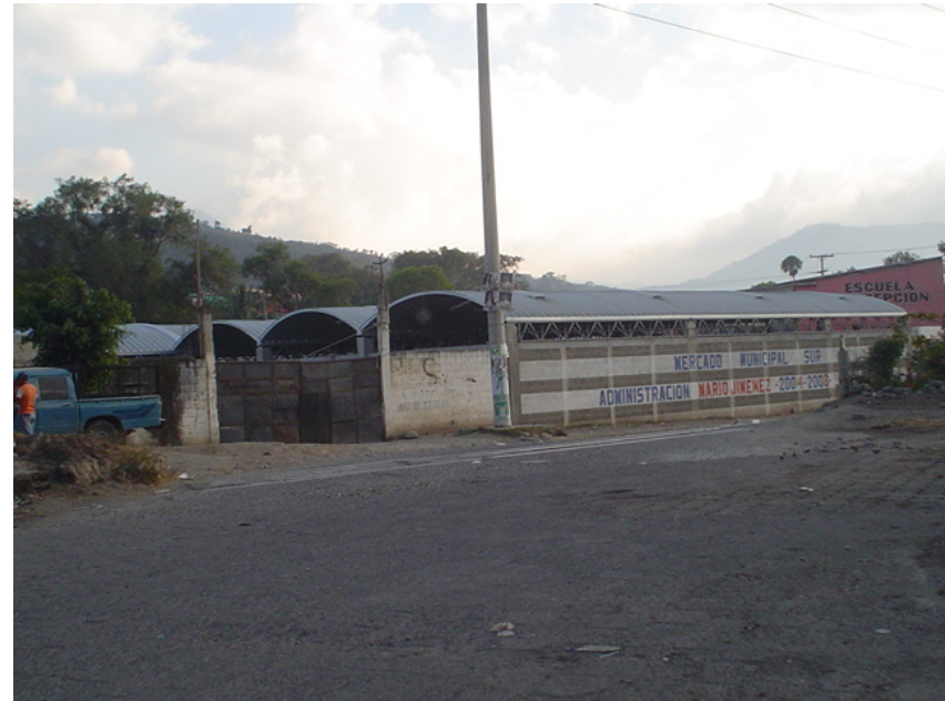
Construcción del nuevo Mercado Sur Amatlán. Elaboración propia. (Fotografía No. 7)
