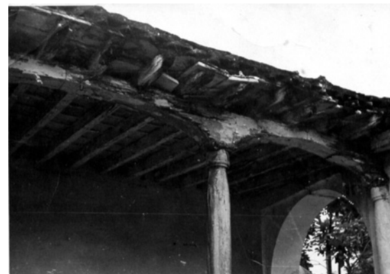
Deterioro de la terraza española, arcos y detalle de columnas.
