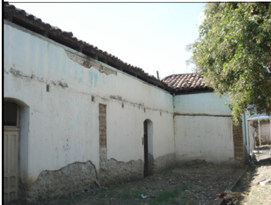
Fotografía No. 94 Estado de conservación fachada noroeste Deterioros: decoloración, fisuras, desprendimiento de materiales, faltantes, alteración de repello, destrucción del techo.
