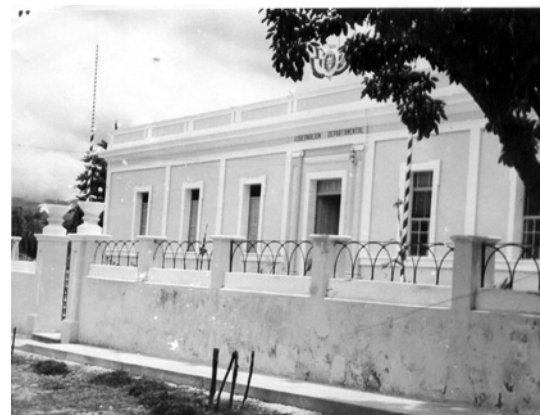
Escuela Normal Rural No. 4, construida en tiempos de Manuel Estrada Cabrera, con muros de adobe.
