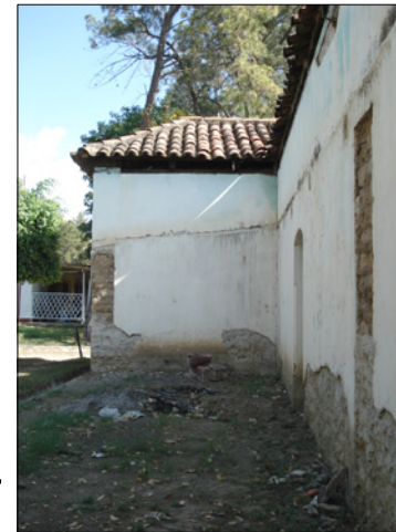
Fotografía No. 94 Estado de conservación fachada noroeste Deterioros: decoloración, fisuras, desprendimiento de materiales, faltantes, alteración de repello, destrucción del techo.
