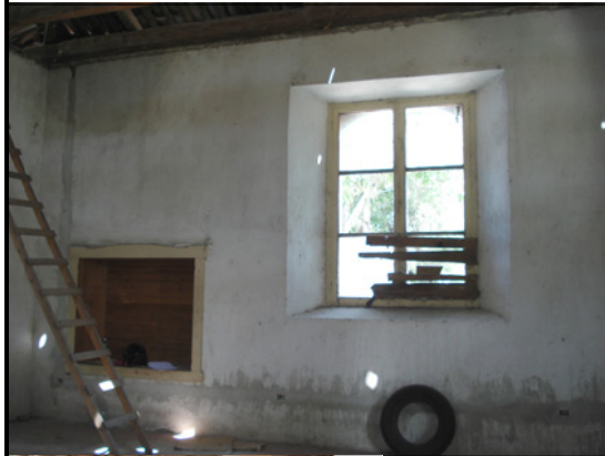
Fotografía No. 105 Estado de conservación fachada suroeste Deterioros: decoloración, fisuras, desprendimiento de materiales, faltantes, alteración de repello, crecimiento de vegetación en techo.
