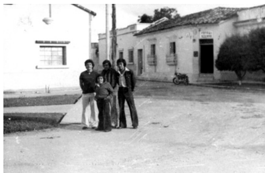
Al fondo, la Agencia del Banco Agrario, en la esquina parte del edificio de Guarderías Nacionales.
